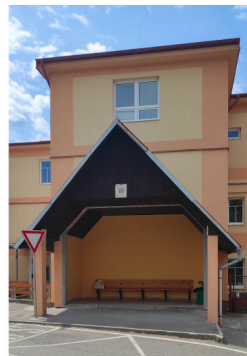
Čekárna po provedených úpravách.
